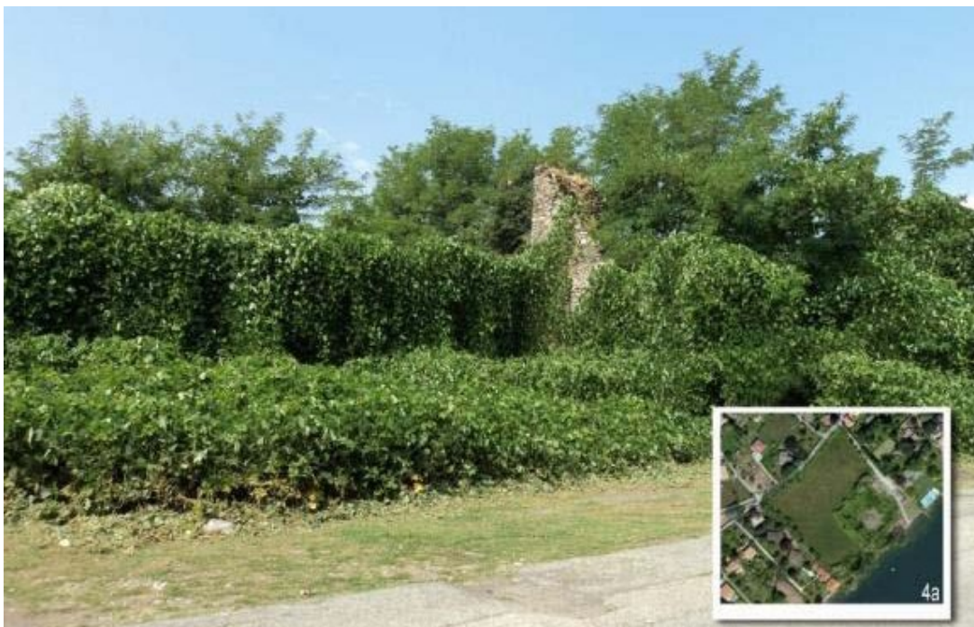
Castle of Lesa (NO), fortified wall - source: Bartolozzi, C. and Novelli, F., Resti e ruderi di strutture fortificate in provincia di Novara: studi per una strategia di conservazione e valorizzazione, p. 115.
